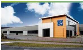
Hoogeveen (Olanda) Controlli elettronici
