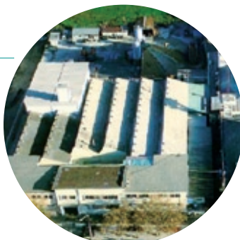
Lisbona (Portogallo) Contatori acqua
