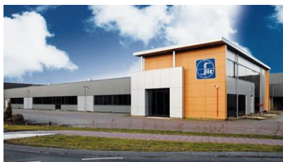
Hoogeveen (Olanda) Controlli elettronici
